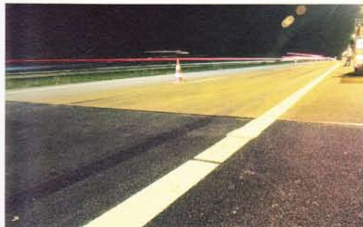
Het door Dura Vermeer ontwikkelde verlichte asfalt ligt bij wijze van experiment op de A35.
